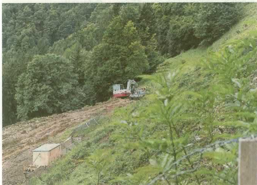
Im steilen Gelände ist fast kein Platz vorhanden, um Material zu lagern.
