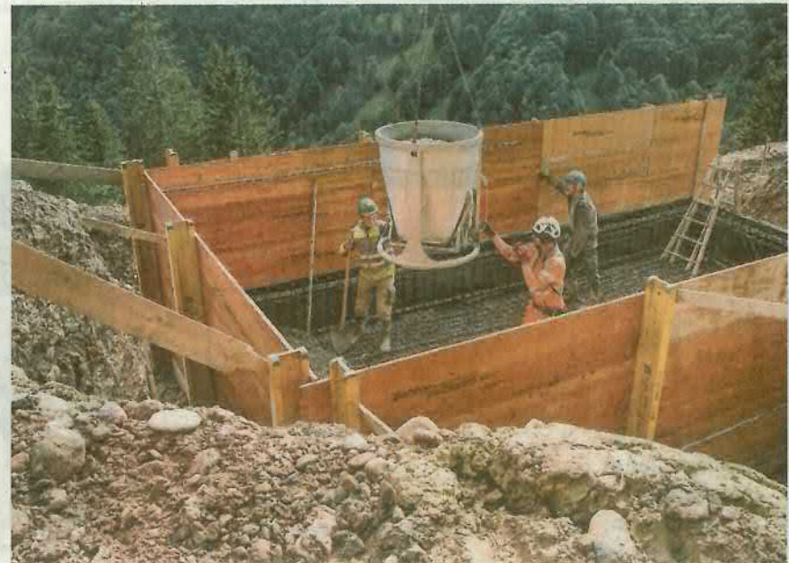
Maurer betonieren den Boden und der Flughelfer gibt dem Piloten Anweisungen.
